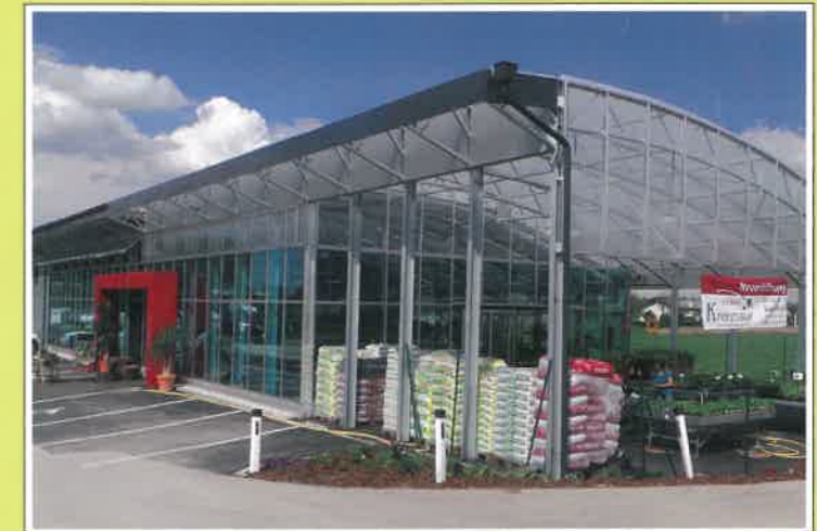
Seitenstehwand mit farbig getönter Isolierverglasung
