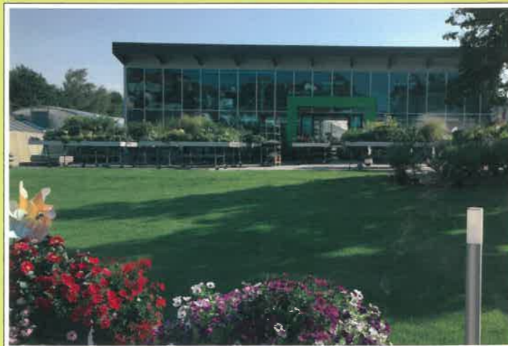
Dacheindeckung mit Sandwich-Isolierpaneele
