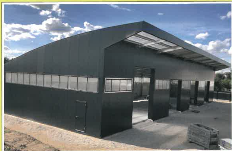
Lagerhalle, Dach und Seitenstehwände mit Sandwich-Paneele
