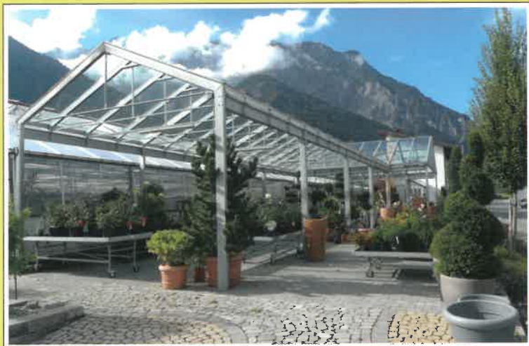
Freiland-Verkaufsüberdachung mit VSG-Glas
